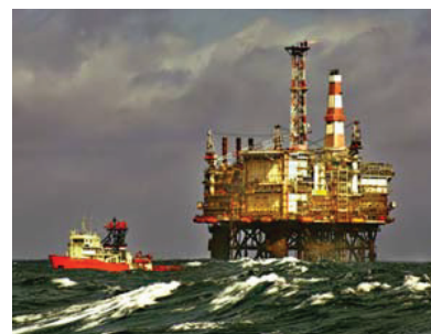
Slika 10.4 Ploščad Magnus v severnem britanskem delu Severnega morja vsebuje 71.000 ton jekla. Leta 2000 je s te ploščadi prišlo 3,8 milijona ton nafte in plina – kar ustreza moči 5 GW. Ploščad je stala 1,1 milijarde funtov. Foto: Terry Cavern.
