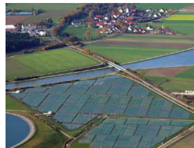
Slika 6.7 Sončna elektrarna: 6,3-megavatni (končna moč) Solarpark v Mühlhausnu na Bavarskem. Njegova povprečna moč na enoto površine na bi bila po napovedih približno 5 W/m 2 . Foto: SunPower.
