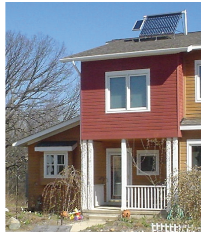
Slika 30.2 Toplotni sprejemnik sončne energije, ki zagotavlja toplo vodo družini v Michiganu. Njegovo črpalko poganja mali fotonapetostni modul na levi.
