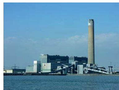
Slika 23.1 Dostava premoga v elektrarno Kingsnorth (zmogljivost 1940 MW) leta 2005. Foto: Ian Boyle, www.simplonpc.co.uk .
