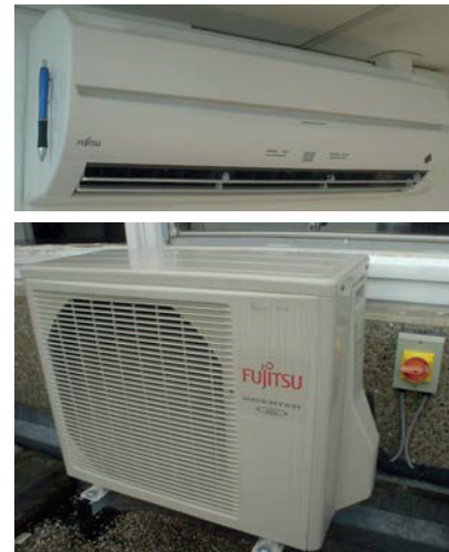
Slika 21.11 Notranji in zunanji del toplotne črpalke zrak/zrak z grelnim številom 4. Za merilo je ob notranjem delu kemični svinčnik. Takšen Fujitsujev sistem zagotavlja 3,6 kW grelni moči, potrebuje pa samo 0,845 kW električne moči. Deluje lahko tudi obratno, pri čemer zagotavlja 2,6 kW hladilne moči in potrebuje 0,655 kW električne.
