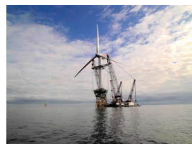
Slika 10.8 Gradnja demonstracijske vetrne elektrarne Beatrice v globokih vodah. Fotografije so prijazno prispevali Talisman Energy (UK) Limited.
