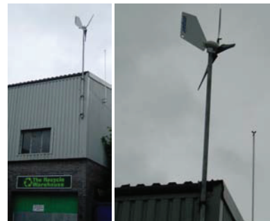
Slika B.9 Mikroturbina Ampair 600 W. Ta mikroturbina, postavljena v mestu Leamington Spa, proizvede v povprečju 0,037 kWh na dan (1,5 W).
