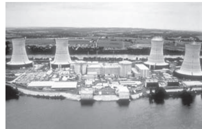
Slika 24.4 Jedrska elektrarna Three Mile Island.
