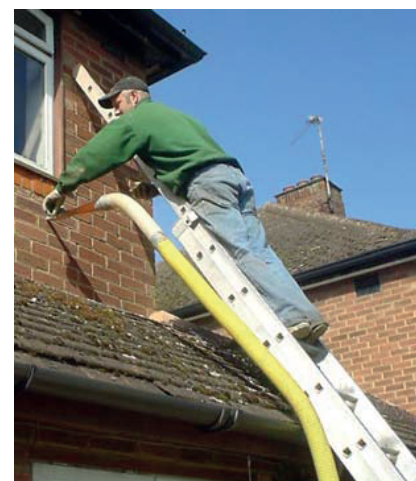
Slika 21.5 Nameščanje izolacije v praznine med dvojnimi zidom.
