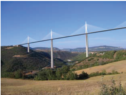
Slika H.7 Viadukt Millau v Franciji je najvišji most na svetu. Jeklo in beton, 2,5 kilometra dolg in 353 metrov visok.
