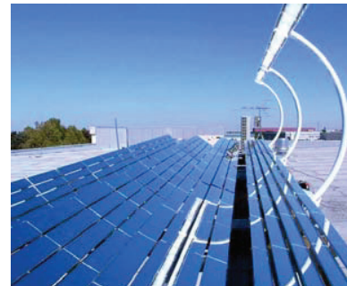
Slika 6.19 Fotonapetostna naprava podjetja Heliodynamics s soproizvodnjo toplote in električne energije. 32 \text{ m}^2 odsevne površine (nekoliko več, kot meri stranica dvanadstropnega avtobusa) proizvaja 10 kW toplote in 1,5 kW električne moči. V državi, ki leži v sončnem pasu, bi s takšno enotonsko napravo lahko zagotovili približno 60 \text{ kWh/d} toplote in 9 \text{ kWh/d} elektrike. To ustreza povprečnim specifičnim močem 80 \text{ W/m}^2 za toploto in 12 \text{ W/m}^2 za elektriko (na kvadratni meter površine naprave); ti so podobni, kot jih zagotavljajo standardni SSE in sončne elektrarne, vendar pa naprave podjetja Heliodynamics po zaslugi koncentradorjev proizvajajo energijo po nižji ceni, saj večino materiala predstavlja preprosto ravno steklo. Za primerjavo: skupna poraba povprečnega Evropejca je 125 \text{ kWh/d} .
