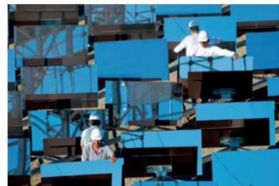
Slika 25.12 Inženirja nameščata sončno termoelektrarno eSolar s heliostati (zrcali, ki z vrtenjem in nagibanjem sledijo soncu). Pri esolar.com izdelujejo srednje velike elektrarne: 33-megavatno (največja moč) napravo na 64 hektarjih. To pomeni največ 51 \text{ W/m}^2 in rekel bi, da bi na tipični puščavski lokaciji zagotovila četrtno te vrednosti: 13 \text{ W/m}^2 .
