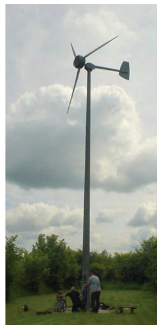
Slika B.10 Turbina Iskra 5 kW [www.iskrawind.com] s premerom 5,5 m med letnim pregledom. Turbina, ki je postavljena v kraju Hertfordshire (ki ni ravno najbolj vetrovna lokacija v Veliki Britaniji) na višini 12 m, dnevno proizvede v povprečju 11 kWh energije. Pri vetrni elektrarni s takimi vetrnimi turbinami, ki bi bile postavljene na mrežo s kvadrati velikosti 30 × 30 m, bi bila moč na enoto površine 0,5 W/m 2 .
