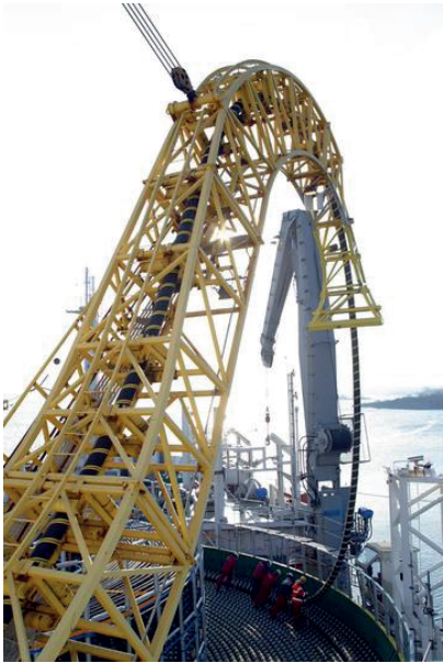
Slika 25.7 Gradnja visokonapetostne enosmerne medomrežne povezave med Finsko in Estonijo. Moč dvojice teh kablov je 350 MW. Foto: ABB.
