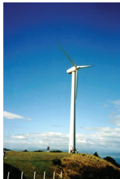
Slika B.3 Vetrnica Brooklyn nad mestom Wellington na Novi Zelandiji z ljudmi ob vznožju za lažjo predstavbo razmerij. Na vetroven dan je ta vetrnica zagotavljala 60 kW električne moči (skupno 1400 kWh na dan). Avtor fotografije: Philip Banks.
