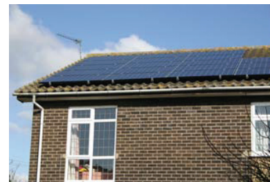
Slika 6.5 Sončne elektrarne: podatki za sistem s površino 25 \text{ m}^2 v Cambridgeshiru leta 2006. Največja moč sistema je približno 4 kW. Celoletno povprečje je 12 kWh na dan. To pomeni 20 W na kvadratni meter elektrarne .
