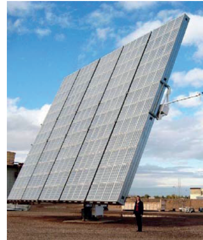
Slika 25.9 25-kilovatni (največja moč) fotonapetostni zbiralnik s koncentradorji kalifornijskega podjetja Amonix. Površina zbiralnika meri 225 \text{ m}^2 , na njej je 5760 Fresnelovih leč s koncentracijo 260 sonc, vsaka pa osvetljuje silicijevo celico s 25-odstotnim izkoristkom. Tak zbiralnik na ustrezni puščavski lokaciji proizvede 138 kWh na dan, kar zadostuje za porabo energije polovice Američana. Za merilo ob napravi stoji človek. Foto: David Faiman.
