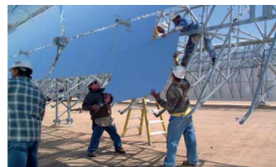
Slika 25.4 Andasol – španska »100-megavatna« sončna elektrarna v gradnji. Presežno toploto, ki jo bo proizvedla podnevi, bodo za največ sedem ur shranjevali v rezervoarjih s staljeno soljo in tako zagotavljali nepretrgano, stabilno dobavo električne energije v omrežje. V elektrarni naj bi proizvedli 350 GWh na leto (40 MW). Parabolična korita se razprostirajo na 400 hektarih, zato bo moč na enoto površine 10 \text{ W/m}^2 . Foto zgoraj: ABB. Foto spodaj: IEA SolarPACES.
