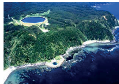
Slika 26.11 Črpalna elektrarna Okinawa, ki za spodnje jezero uporablja ocean. Shranjena energija: 0,2 GWh. Objavljeno z dovoljenjem J-Power. www.ieahydro.org .
