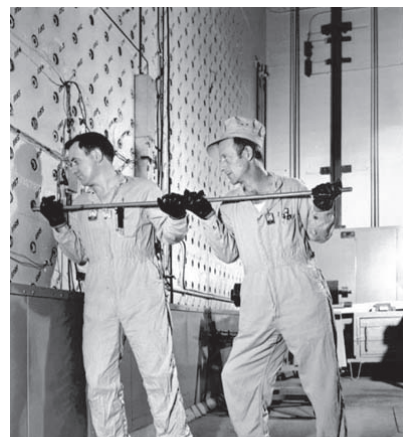
Slika 24.3 Delavca potiskata gorivo v grafitni reaktor X-10.
